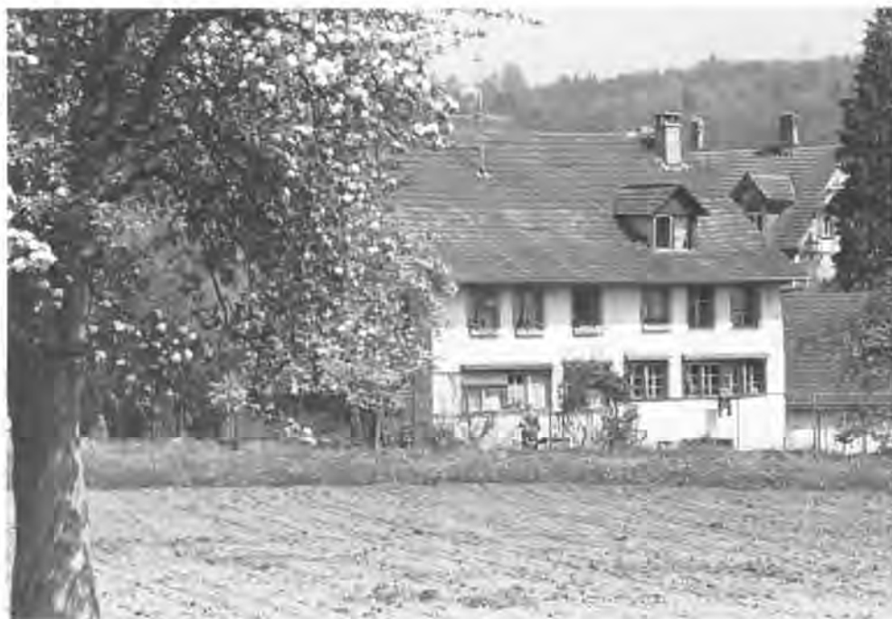
Das Haus an der Alten Dorfstrasse 5. Ansicht von Süden. 1982.
